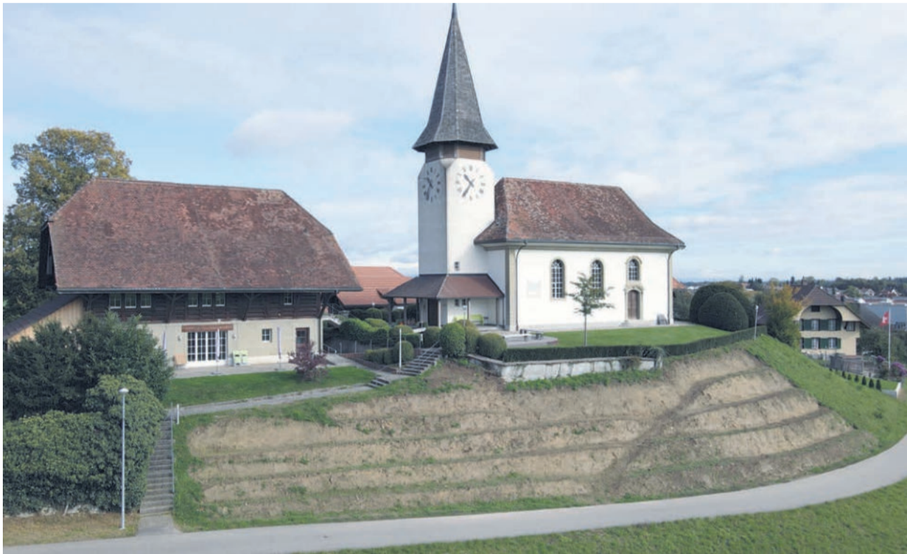
Am Südhang der Kirche in Grafenried entsteht ein Rebberg. Die Terrassierung wurde im Herbst gemacht. Letzten Samstag wurden die Reben gesetzt. Blickpunkt Seite 6.
